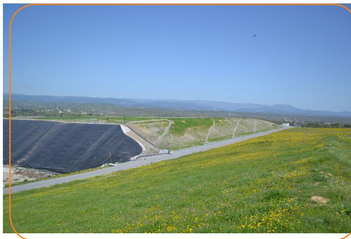
En 2017, un chantier de grande envergure s'est déroulé sur l'ISDND du mois de mai jusqu'à la mi-juillet : le SICTOBA a réhabilité définitivement les alvéoles 2 et 3 du casier 5. L'objectif poursuivi étant de limiter au maximum la production de lixiviats et de permettre le captage et le transport du biogaz dans les meilleures conditions afin de limiter les dégagements d'odeurs. Suite à la réhabilitation définitive de ces deux alvéoles, l'exploitation de la dernière alvéole a pu démarrer.
