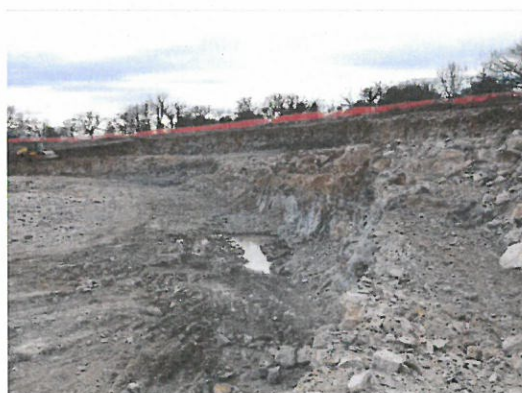
Travaux de terrassement
