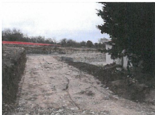
La future entrée de la déchetterie de Ruoms
