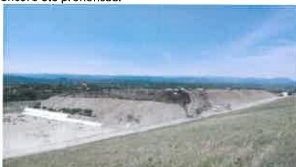
Reprofilage du massif de déchets et dépôt des matériaux de confinement
