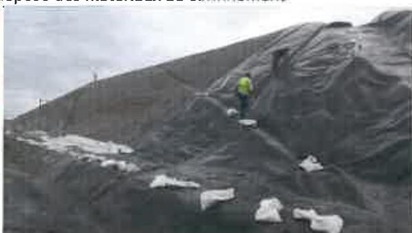
Pose du dispositif d'étanchéité par géosynthétiques
