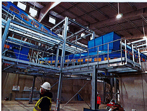
Vue sur le process en cours d'installation
