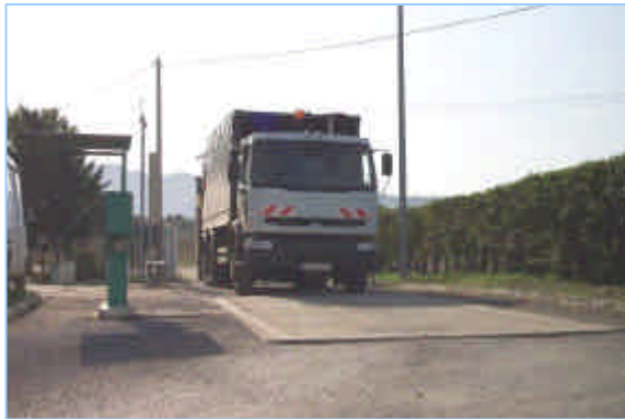
Entrée du CSDU : portail de détection de la radioactivité et pont de pesée
