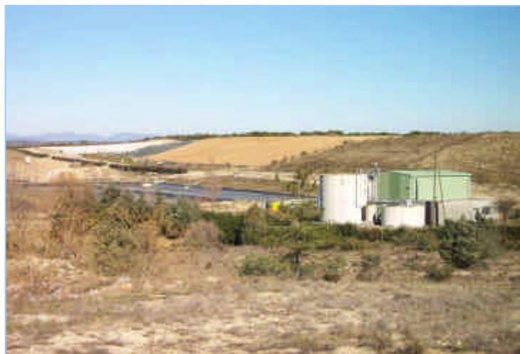
Vue du CSDU et de la station d'épuration
