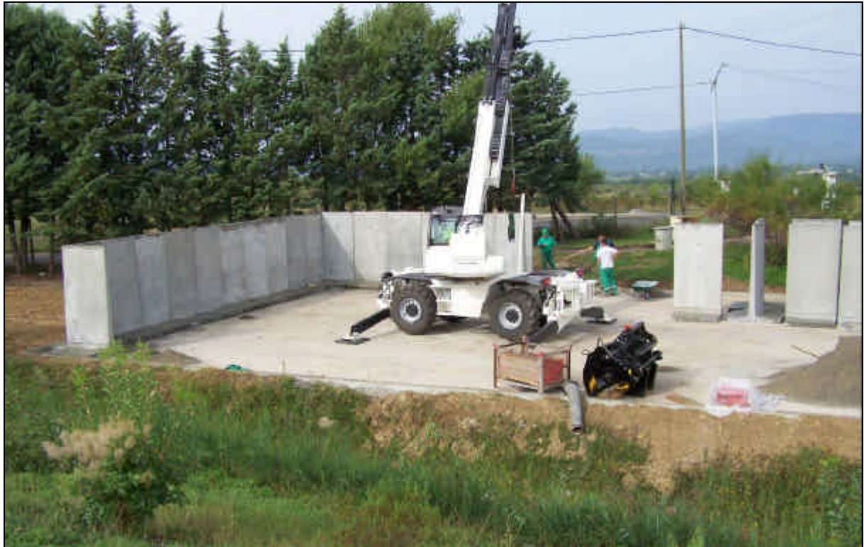
Construction de la plate forme de transfert des ordures ménagères (sept. 2008)
